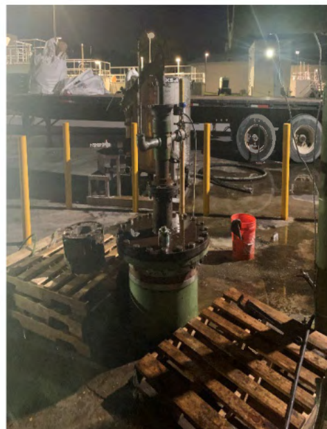
Deep Injection Well MIT Wellhead Disassembly
