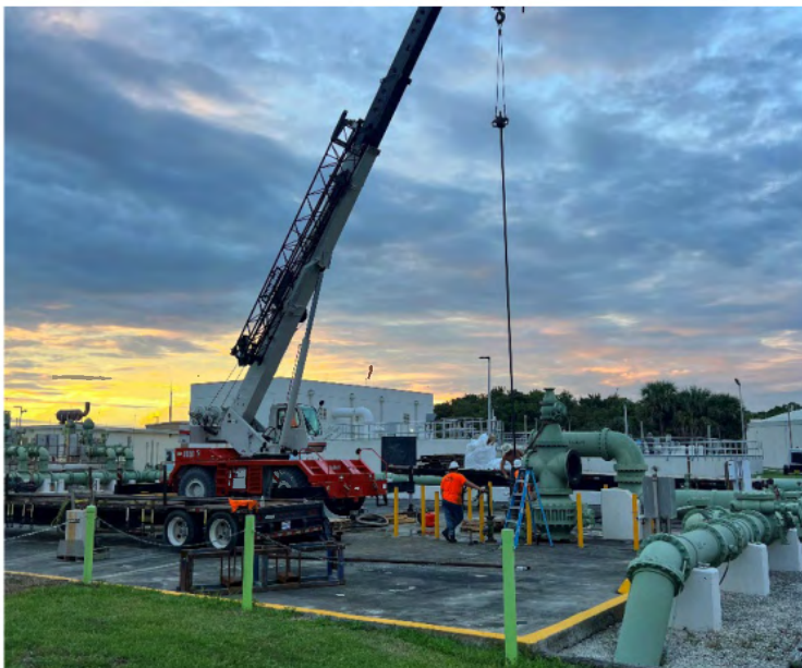
Deep Injection Well MIT Wellhead Disassembly
